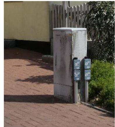
Abb. 131: Kabelverteilerschrank (Alter Zimmerplatz)
